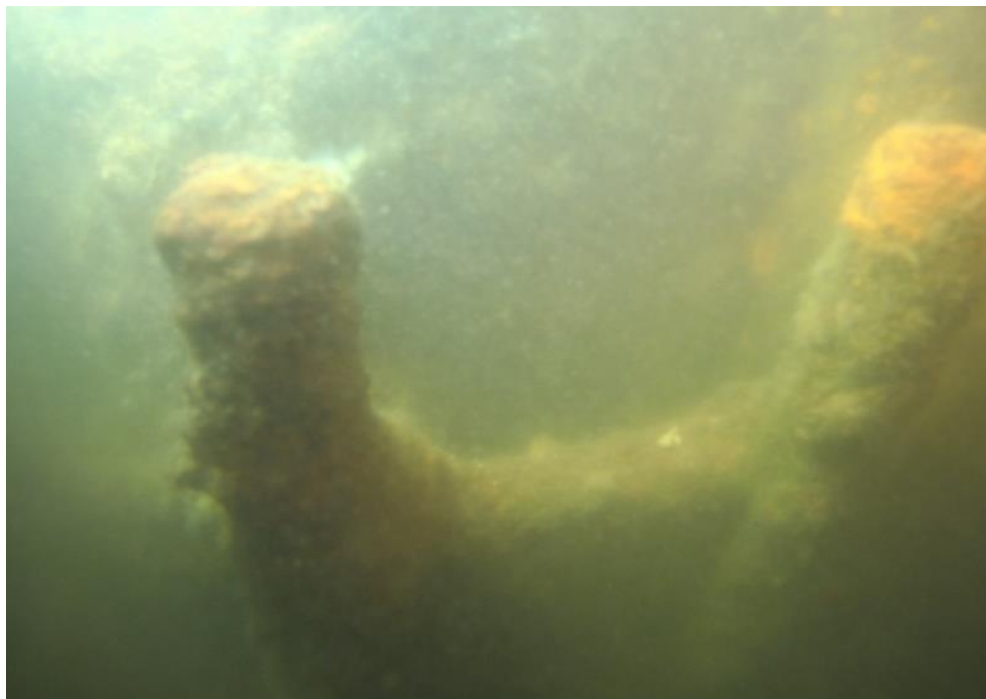
Obr. PS, a.s. VPK dolní ohlaví, odhalené armování u svislých štětovic
